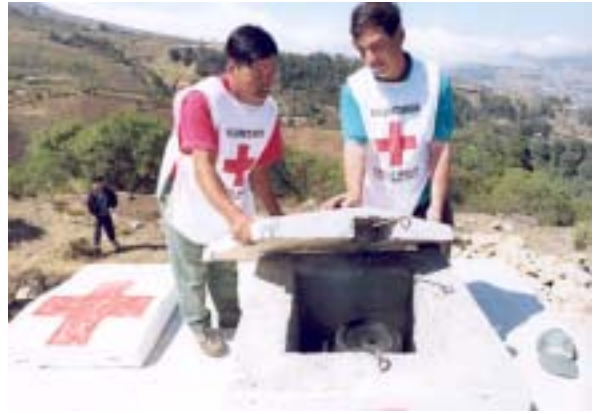
Voluntarios de la localidad de El Rodeo muestran cómo funciona el sistema de tratamiento del agua en dos tanques que contienen 35.000 litros de agua, suficiente para abastecer a la comunidad.
