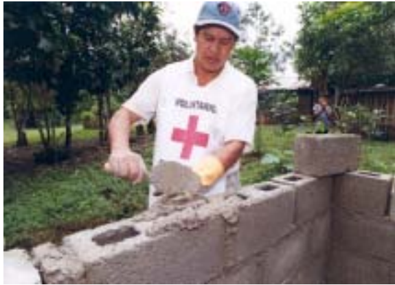
Un voluntario guatemalteco construye una letrina en la comunidad de Scoyou, al norte del país.
