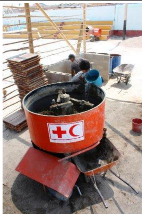
En San Clemente (Pisco), miembros de la comunidad elaboran bloques de tierra comprimida con cemento para la construcción de sus viviendas. Federación Internacional / J.Ormeño
