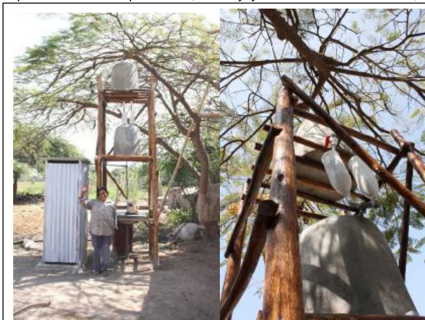
Soluciones de agua y sanitarias son provistas junto con las viviendas. En Independencia (Pisco), este componente del programa se desarrolla en trabajo conjunto con Paz y Esperanza. Federación Internacional / J. Ormeño
